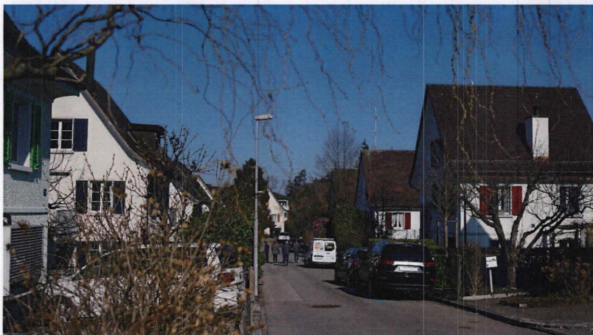
Linke Seite Agleistrasse 10, 8, 6. Rechte Seite Agleistrasse 9, 7 von Agleistrasse aufgenommen
