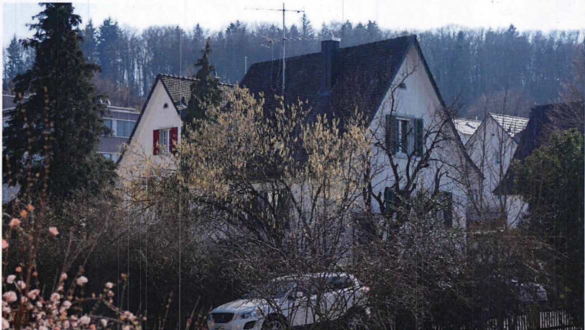
Agleistrasse 5 dahinter Glaubtenstrasse 8 von Obsthaldenstrasse aufgenommen
