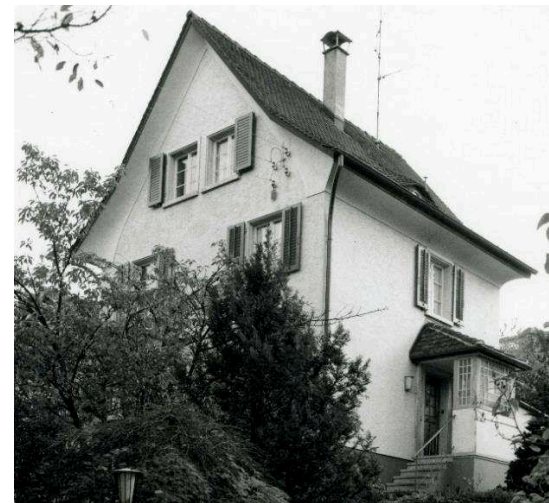
Obsthaldenstr.55, 1928, Wohnhaus Karl Trutmann (spätestens ab 1930)
